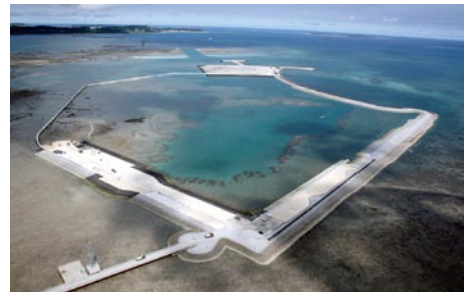
上空500mから見た泡瀬干潟埋め立て工事の現場。(2008年5月8日)
