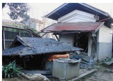
井戸の屋根が倒れ、土蔵が崩れかかっている栗原市の自宅の様子 (呉地)
