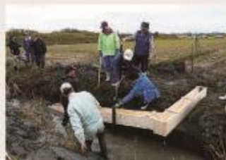
設置作業の様子
