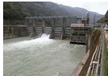
荒瀬ダムの上流にある瀬戸石ダム
