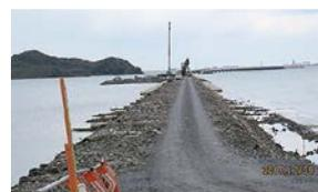
仮設道路が干潟の中央を南北に分断している漁港連絡橋工事
